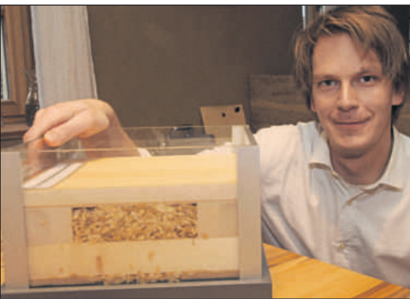
So sieht der Fußboden aus, erklärt Stefan Thar: Lattung, Isolierschicht aus Holz und Lehm, Massivholz drauf.
