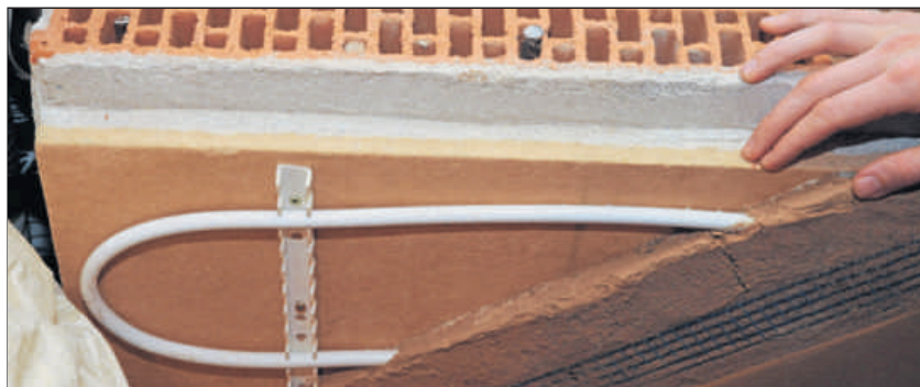
An die Wand, das zeigt das Schnittmodell, kommt die Trägerschicht aus Holzfasern, dann die Wandheizung und schließlich der Lehmputz.
